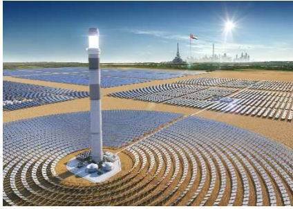
Abbildung 3: Solarturmkraftwerk (BASF Österreich GmbH, 2021)
